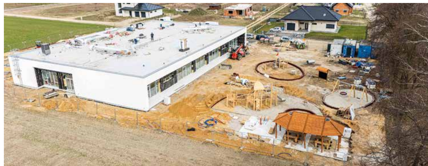
Budowa nowego Przedszkola w Donaborowie
