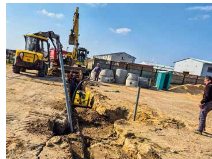
Budowa kanalizacji sanitarnej w Jankowach
