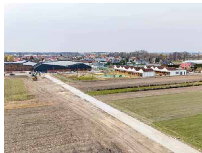
Budowa kanalizacji sanitarnej na ul. Olimpijskiej w Baranowie
